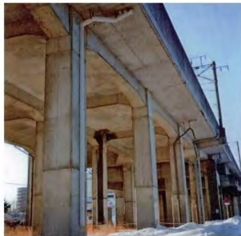
◆鉄道高架橋FRP半円管◆
