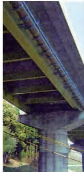
◆ 東名自動車道 大井川橋 (鋼上部工) 工事
