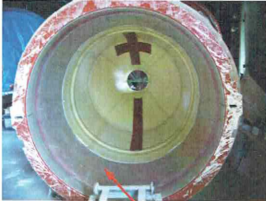
養生パイプに成形作業は行わない 【画像 1】（内部全景）
