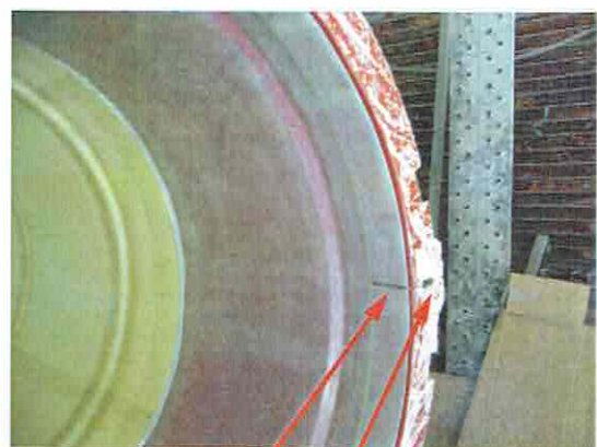
養生パイプ横線と割型を合わせる 【画像 4】（養生パイプ右側）
